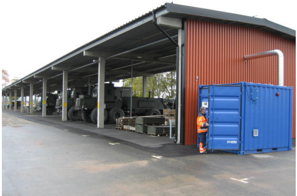
Bild 86. Container med avfuktare och P 4 styrning
