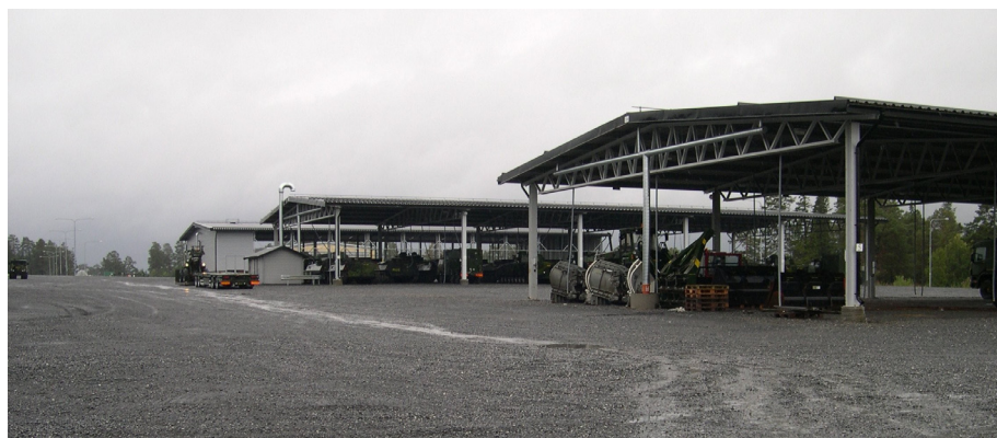
Bild 67. Avfuktning vid skärmtak
