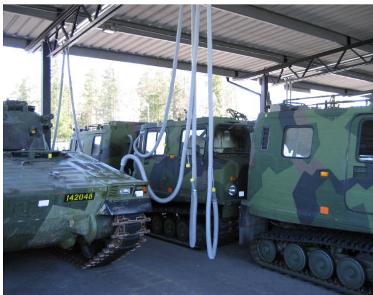
Bild 19. Skärmtak med avfuktare för uppställning av fordon.
