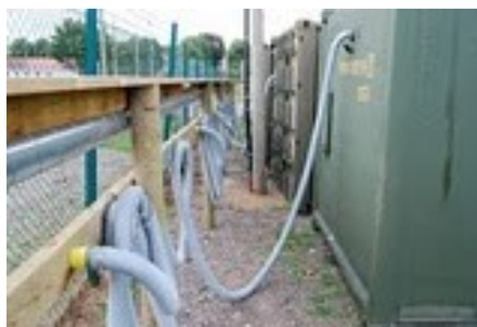
Bild 17. Dynamiskt avfuktade containrar.
